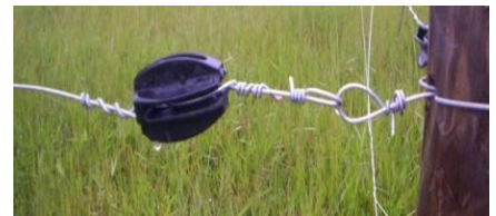
Terminal com dobradiça e castanha
