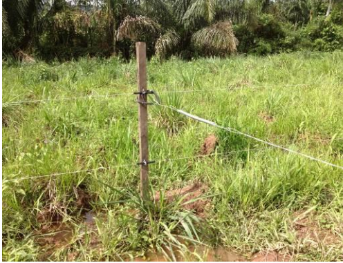
Cerca móvel - terminal de mola: início da instalação
